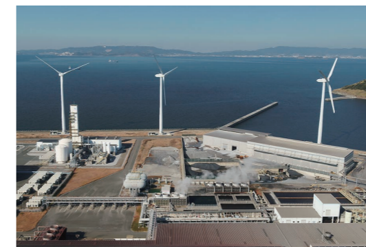
田原工場の圧延水処理設備
