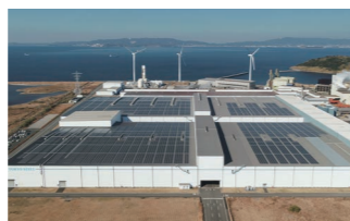
太陽光パネルを設置した田原工場製品倉庫屋根
