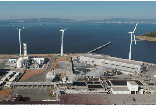
田原工場の圧延水処理設備
