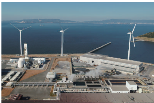
田原工場の圧延水処理設備
