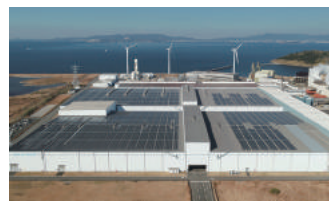
太陽光パネルを設置した田原工場製品倉庫屋根
